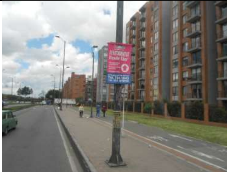
FOTO 3. ELEMENTOS INSTALADOS SOBRE POSTE EN LA AVENIDA CARRERA 72 CALLE 24 del 26-07-2014.
